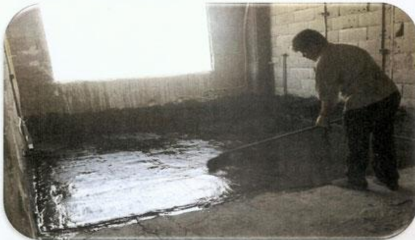
عایق کاری سرویس آشپزخانه و بالکن
