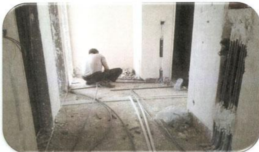
اجرای لوله برق از کف طبقات 18 الی 21
