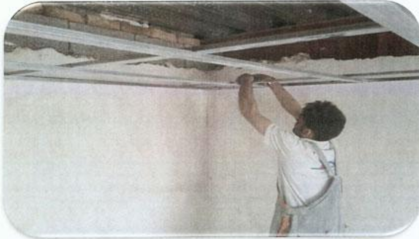
زیر سازی سقف گاذب طبقه 15
