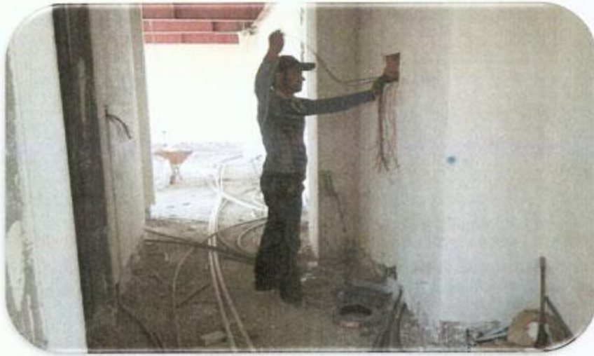
سیم کشی برق از کف
