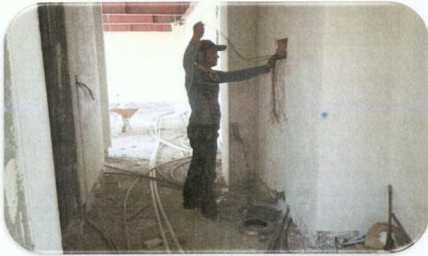
سیم کشی برق از کف
