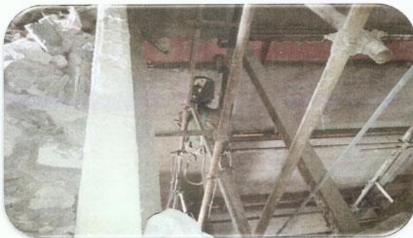
جوشکاری شاسی آسانسور ضلع شرقی
