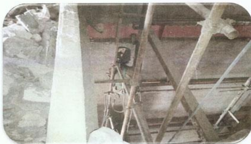
جوشکاری شاسی آسانسور ضلع شرقی
