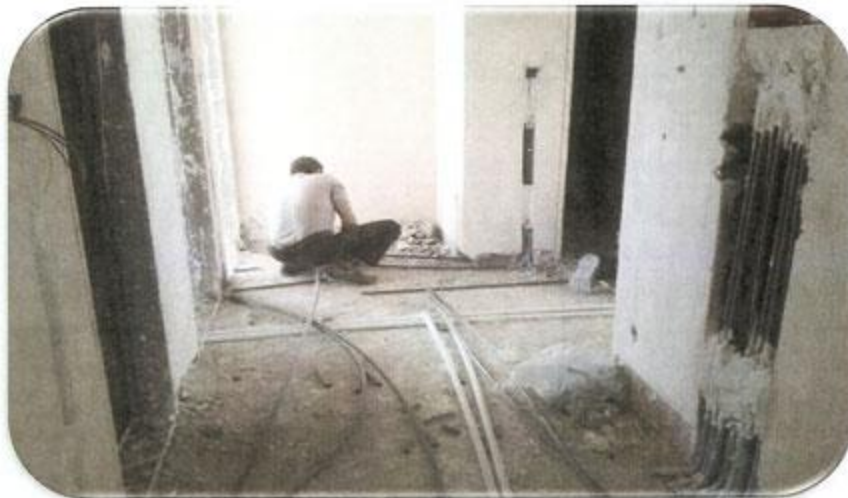
اجرای لوله برق از کف طبقات 18 الی 21
