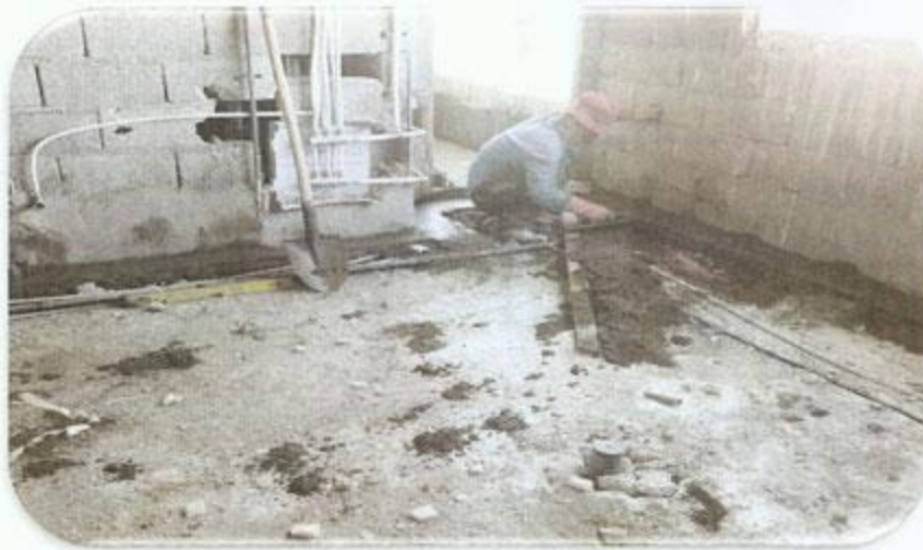
کف سازی و شیب بندی
