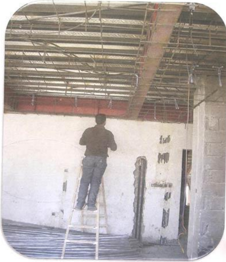
عبور لوله های برقی در واحد غربی طبقه ۲۱
