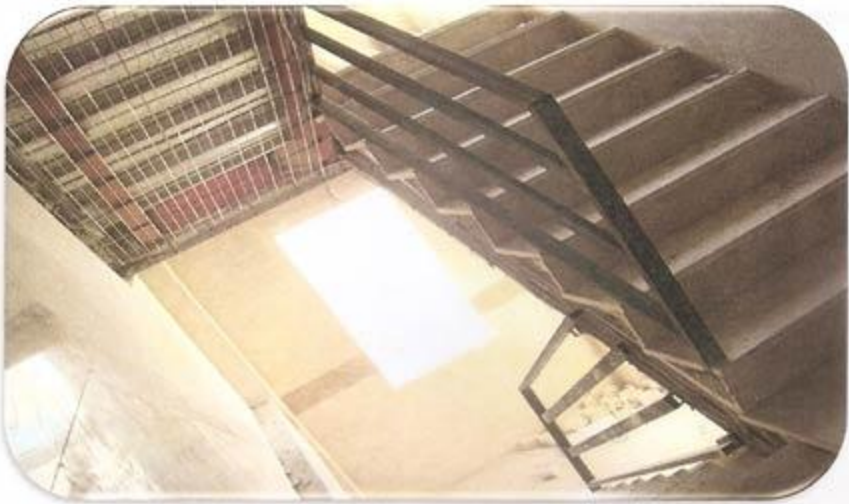
نصب توده راه پله طبقه ۱۶
