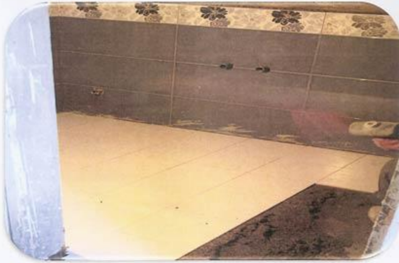
اجرای کاشی و سرامیک حمام مستر واحد A طبقه ۱
