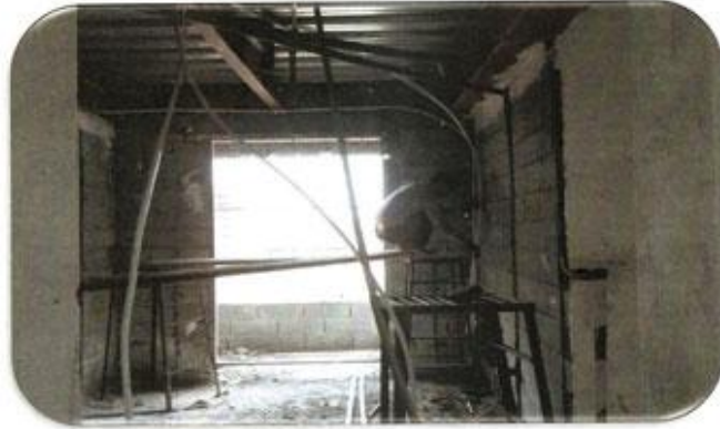
اجرای لوله آب مصرفی
