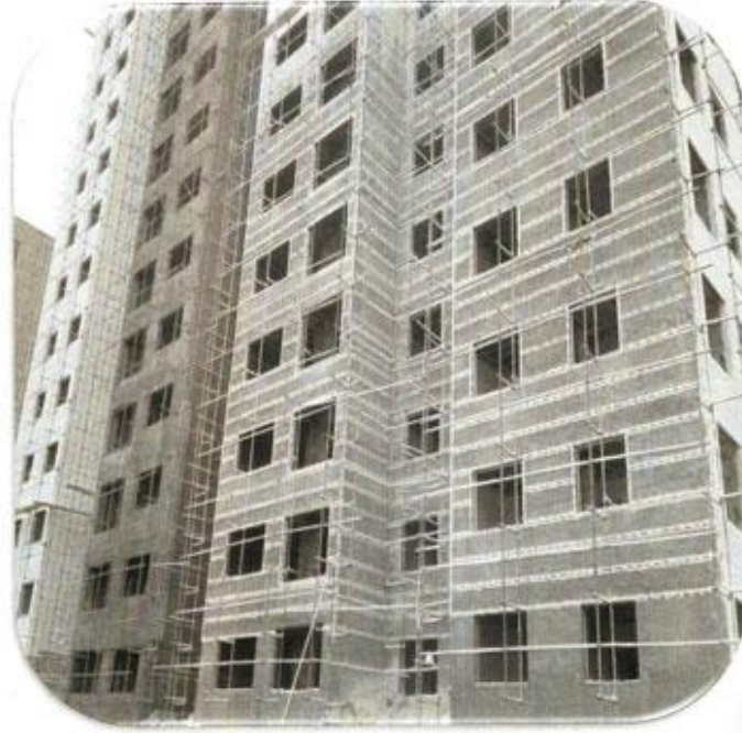
شیشه گذاری نمای شمال غربی
