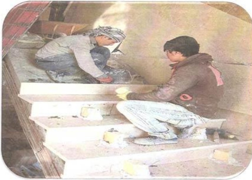
اجرای سنگ پله طبقه ۱۸ ضلع غربی
