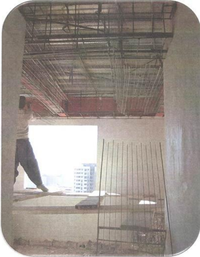
رابطس کاری سقف واحد شرقی طبقه ۲۱
