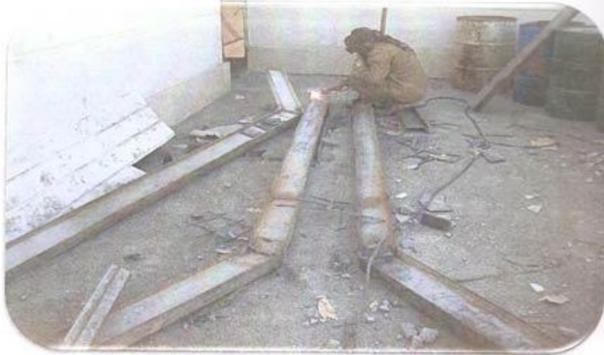
اجرای شمشیری پله هلی پد
