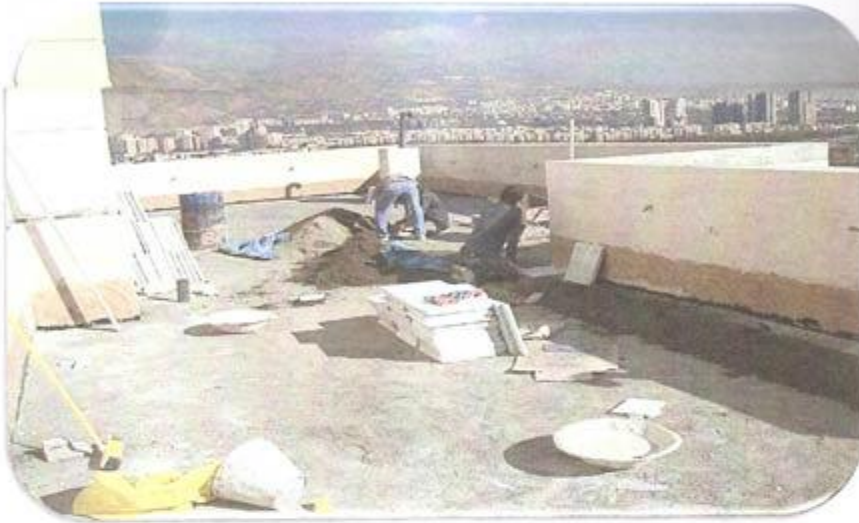
اجرای سنگ گد، پام طبقه ۱۷ ضلع شرقی
