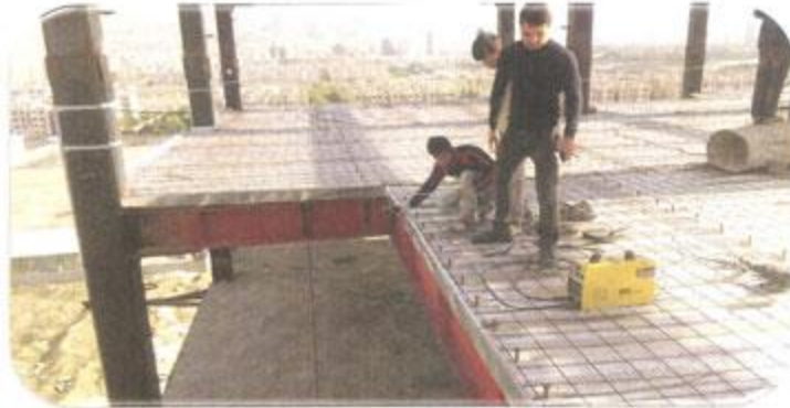
آماده کردن سقف طبقه دهم
