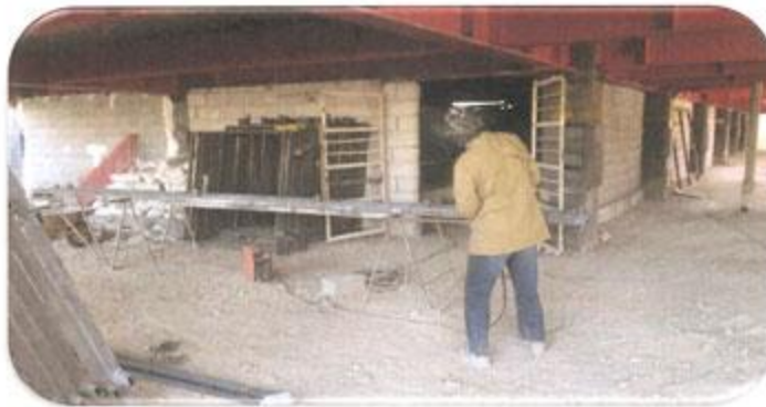
ساخت نعل درگاه
