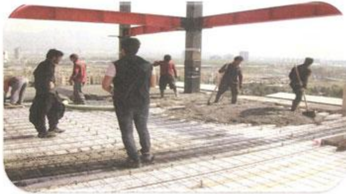
پاشن ریزی سقف
