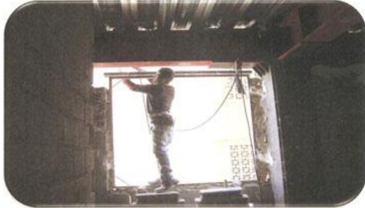
نصب نعل درگاه و فریم پنجره طبقه ۸تف
