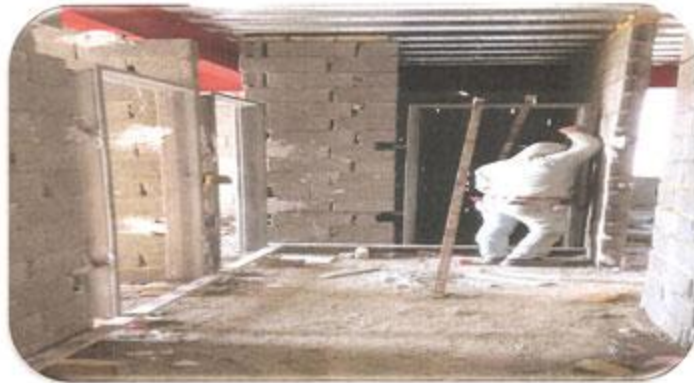
نصب چهارچوب های طبقه ۶.۷.۱
