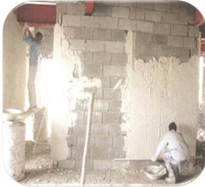
گچ کاری طبقه اول (در حال اجرا)
