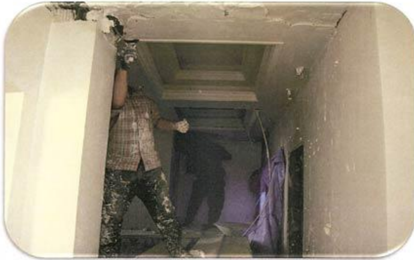
سفید کاری سقف راهرو واحد غربی طبقه ۲۱
