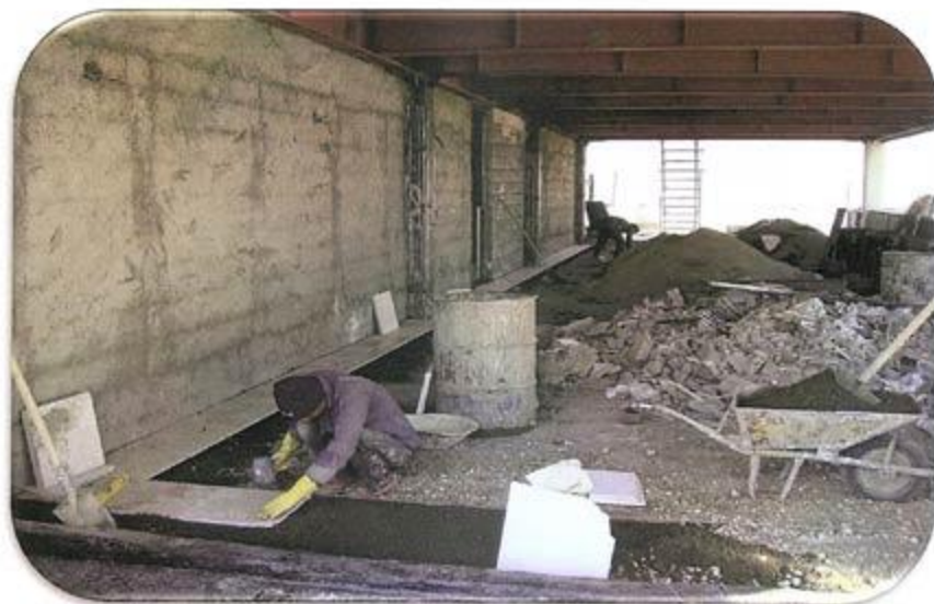
اجرای سنگ کف طبقه ۲۲ (زیر هلی پد)
