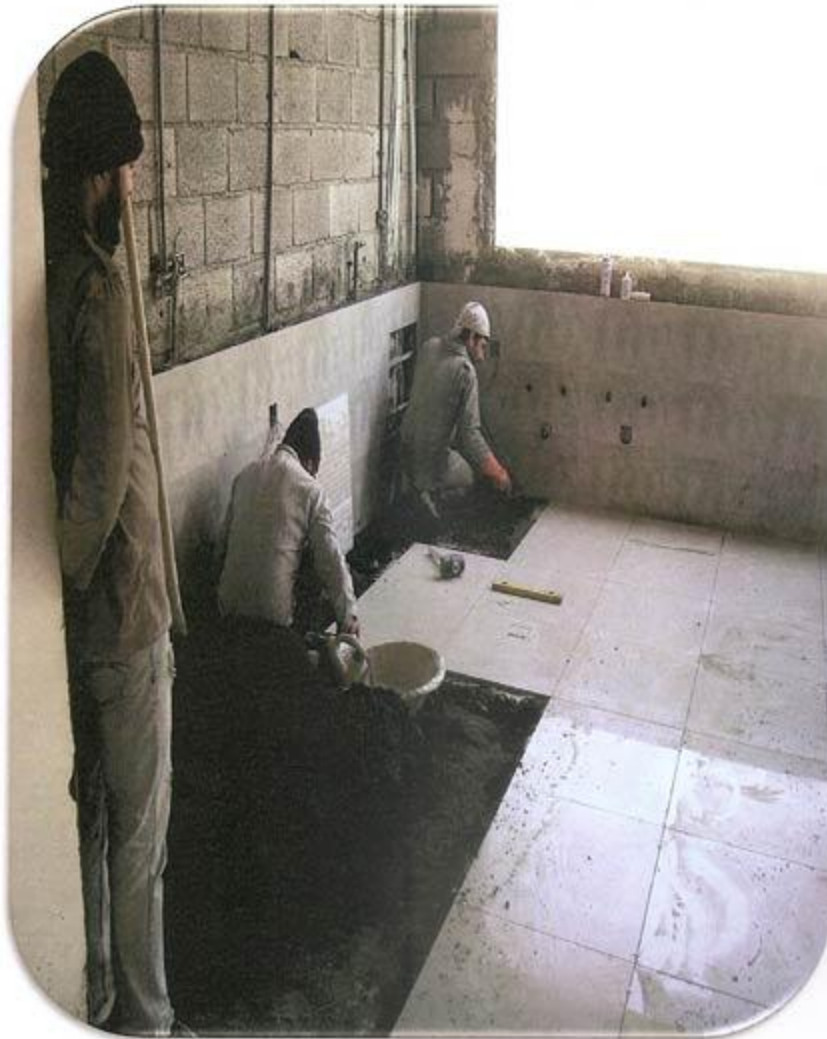
اجرای سرامیک کف سالن واحد غربی طبقه ۲۱
