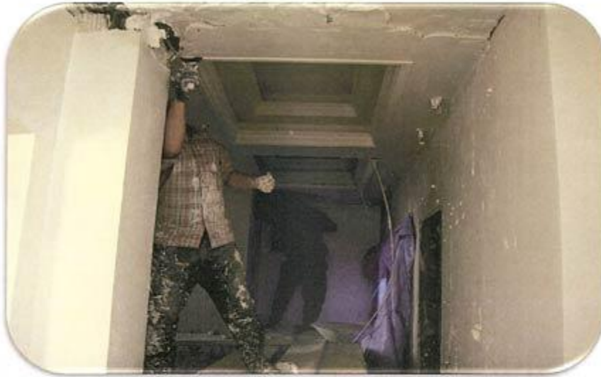
سفید کاری سقف راهرو واحد غربی طبقه ۲۱
