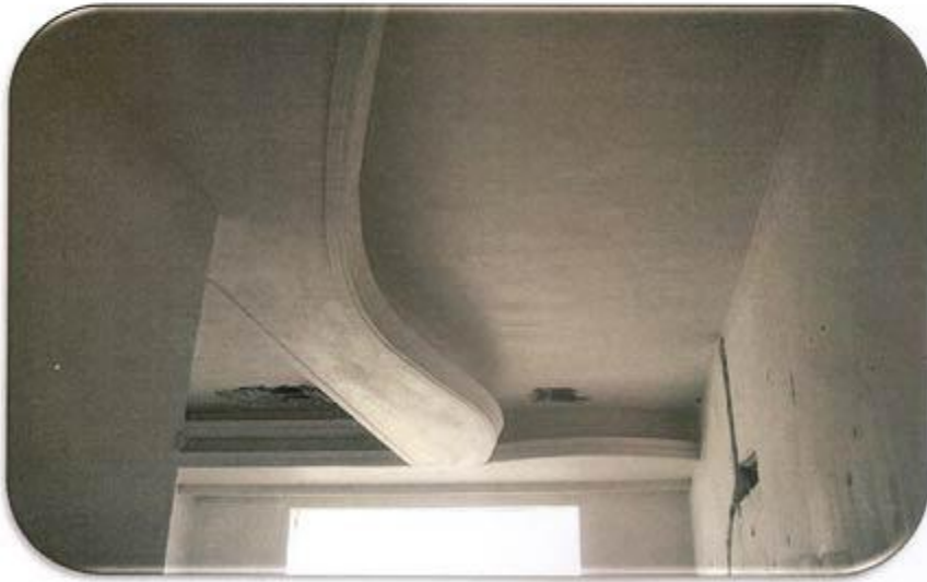
سفید کاری سقف اتاق خواب واحد شرقی طبقه ۲۱
