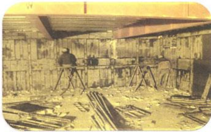
بازکردن قالب ضلع غرب طبقه ۲-
