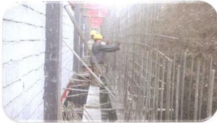
بالتن میلگرد دیوار ضلع شمال بستن قالب های دیوار ضلع شمال طبقه ۲-
