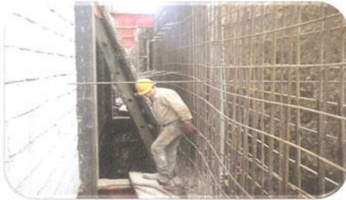
بازکردن و انتقال قالب از طبقه ۲ به ۱-
