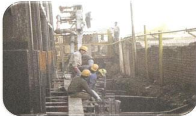
پتن ریزی دیوار ضلع شمال طبقه ۱-
